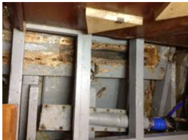
Le tube d'étambot déposé laisse apparaître le bloc et permet d'évaluer si il devra être changé ou réparé. Dans le prolongement du tube d'étambot, le presse étoupe à joint céramique.
