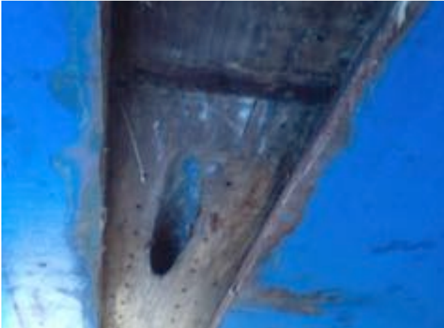
Le bloc vu du dessous après démontage du bordé.
