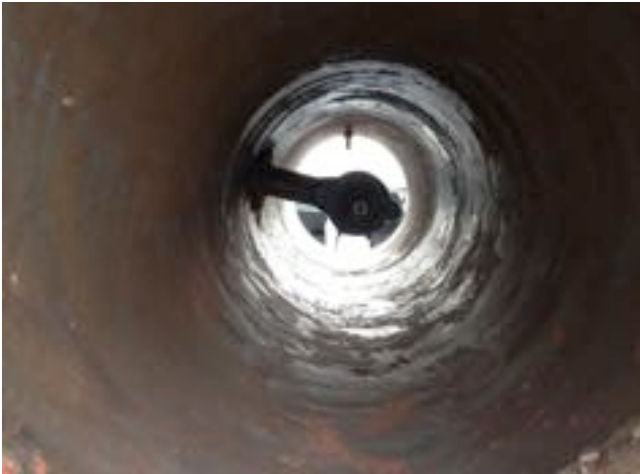
Le tube du propulseur après sablage permet un contrôle rigoureux de l'état de surface : RAS
