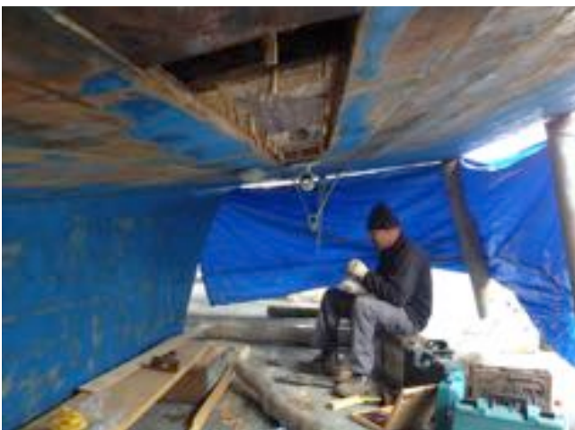
Reprise des parties abimées par des inserts.
