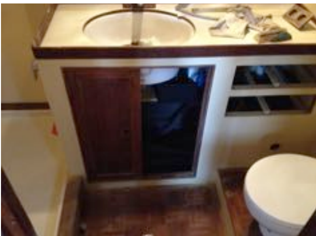
La salle de bain est entièrement repeinte, vernie, un nouveau revêtement est posé pour l'étanchéité de la douche et le vaigrage fatigué par les ans est remplacé.
