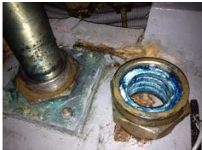
Avant d'installer les tables de nuit les tresses du presse étoupe des tubes de jaumière sont remplacées.
