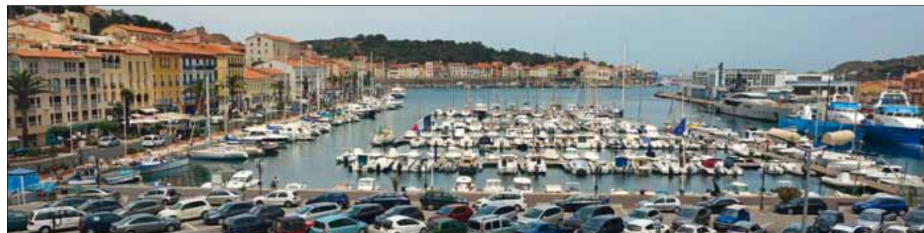
Le port de plaisance compte 250 emplacements. Les quais du port de commerce peuvent également accueillir des grands yachts de passage.
